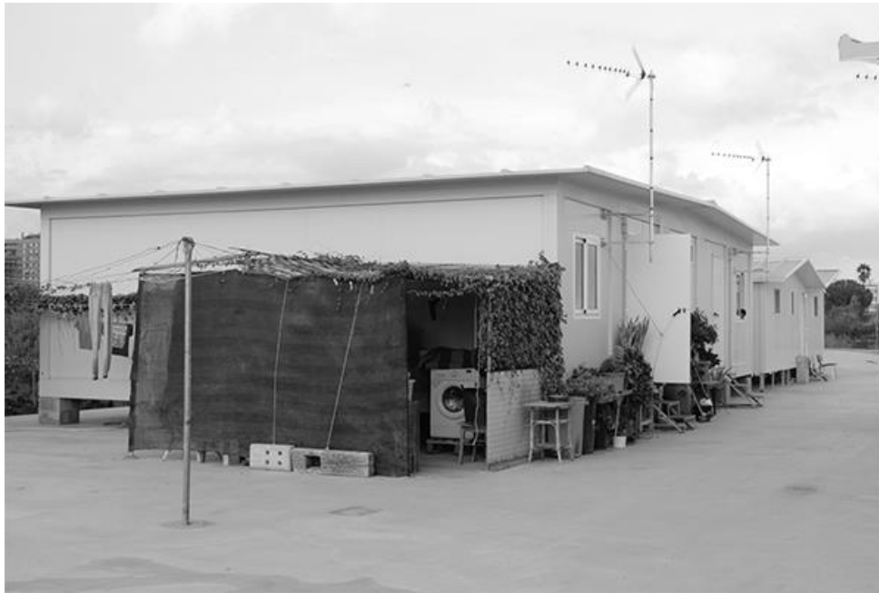
Fig. 1 Vivienda de emergencia en Lorca
