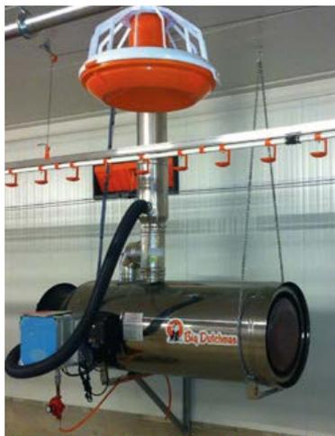
Generador de aire caliente con combustión externa y salida de gases al exterior.
