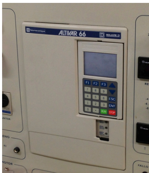
Figura AI.5. Variador de frecuencia Altivar 66 de Telemecánica.
