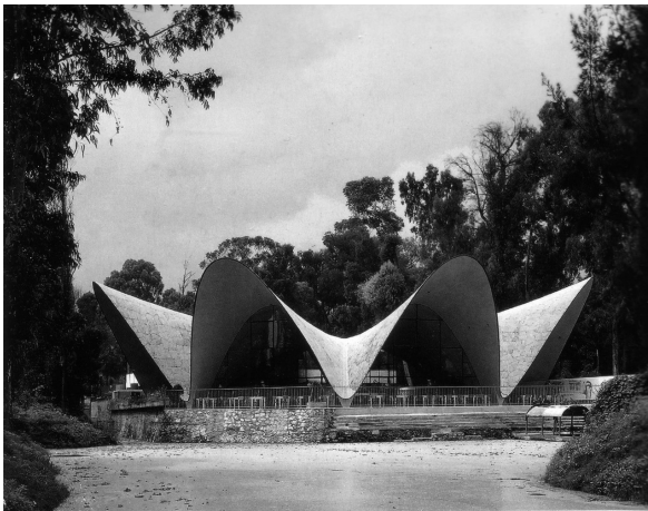
Imagen. 65 Restaurante Los Manantiales de Félix Candela con el plegado de hormigón armado de sus cubiertas.
