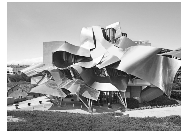
Imagen 71. Fachada de acceso hotel Marqués de Riscal diseñado por Frank Gehry
