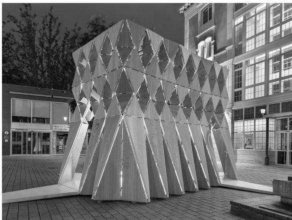
Imagen 122. Construcción temporal de madera con pliegues en toda su forma en las cuatro caras.
