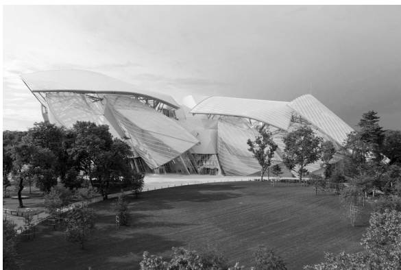
Imagen 37. Edificio de la casa comercial Louis Vuitton en la ciudad de París diseñada por el arquitecto Frank Gehry como un vestido blanco puro en movimiento.
