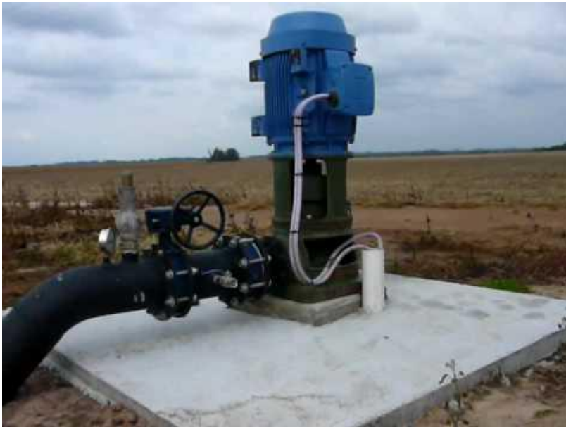
Figura 4: Componentes del cabezal de riego. Fuente: Buscador de imágenes de Google.
