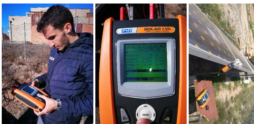
Imagen nº 36: trazador SOLAR I-Ve con un ejemplo de los parámetros del fabricante que metemos de cada panel y como se toman las medidas. Fuente: Elaboración propia.
