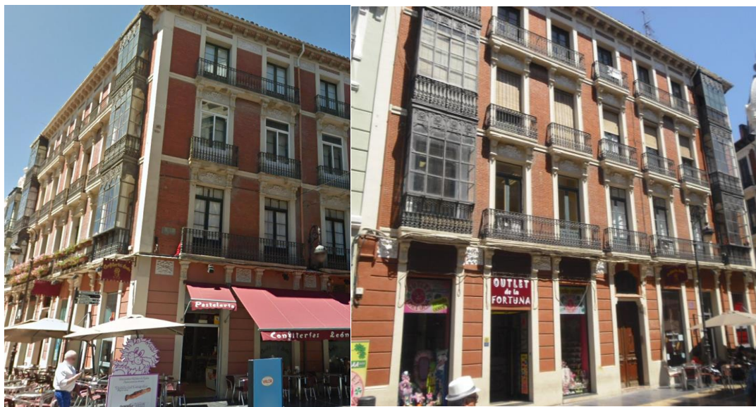
Figura 39 y 40: fachadas en la esquina C/Ancha y C/Sierra de Pambley. Autora (julio 2019)
