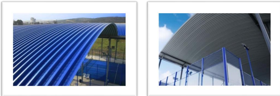
Imagen 25. Imagen de las pistas ya terminadas en nuestras instalaciones
