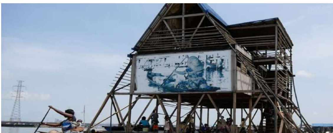
Fig. 5.18 Colegio flotante en Makoko (Lagos), adaptado a vivir sobre el agua. Véase Anexo 1.
