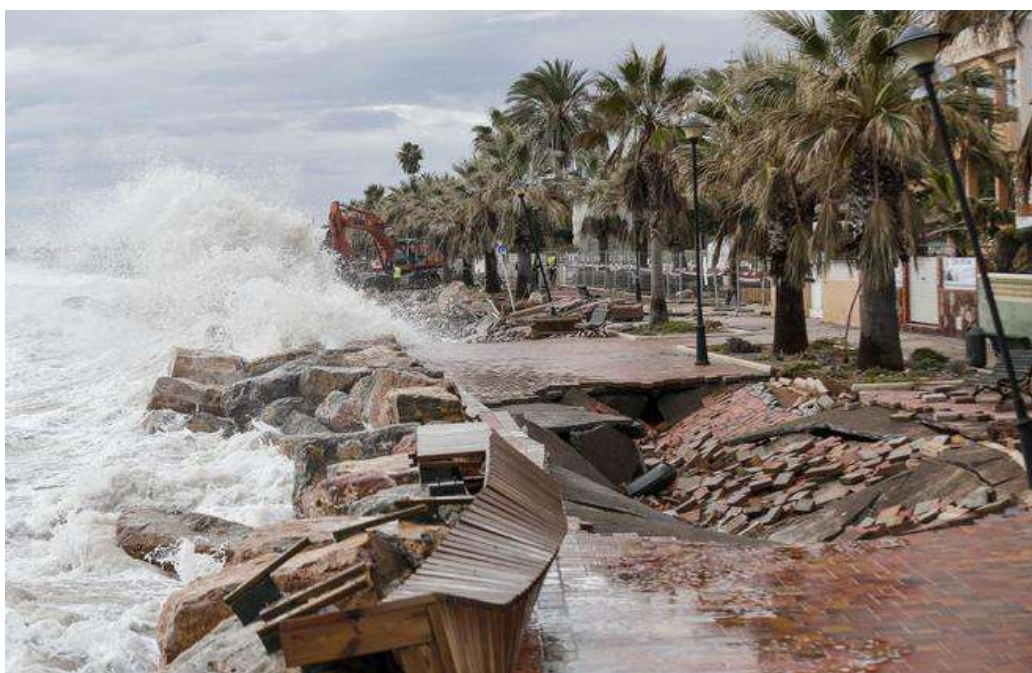
Fig. 3.7 Temporal que afecta al paseo marítimo de Almenara (Castellón). Véase Anexo 1.
