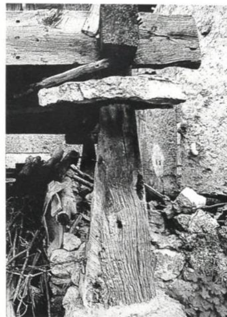
[Figura 32]. Sujeción de la parte inferior del hórreo.
