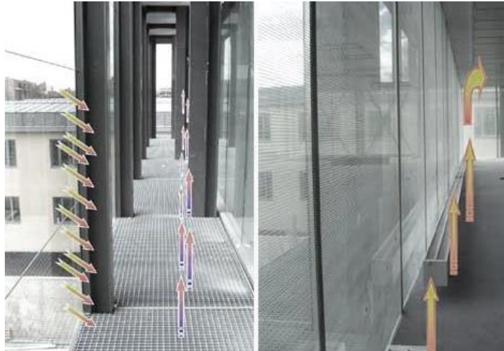
[Figuras 40 y 41]. Vistas interiores de la galería que permite crear un efecto Muro Trombe.
