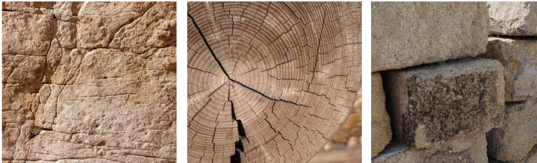
[Figuras 19, 20 y 21]. Materiales utilizados en la arquitectura vernácula: Adobe - Madera – Piedra.
