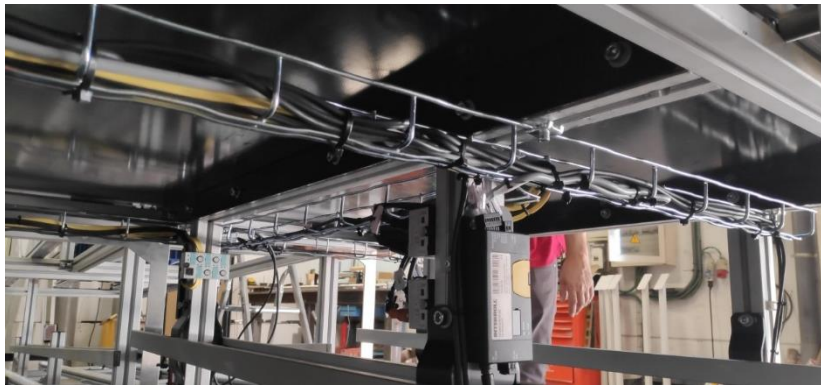
Fig.49. Montaje de Rejiband
