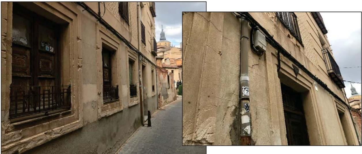
Ilustraciones 43 y 44. Inmueble en mal estado (nº 2). Cableado a la vista y mal dispuesto, ventanas rotas...
