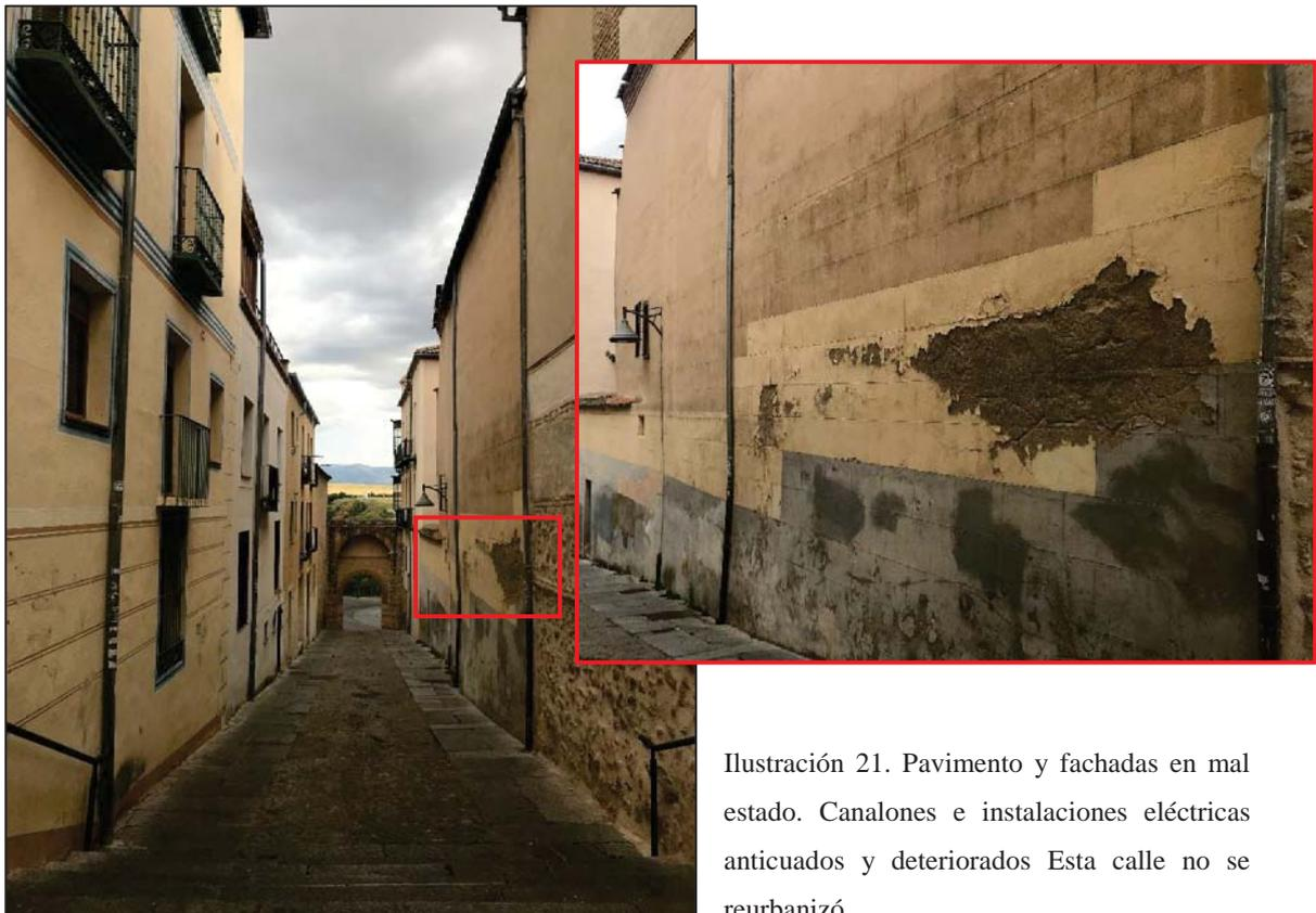
Ilustración 21. Pavimento y fachadas en mal estado. Canalones e instalaciones eléctricas anticuados y deteriorados. Esta calle no se reurbanizó.
