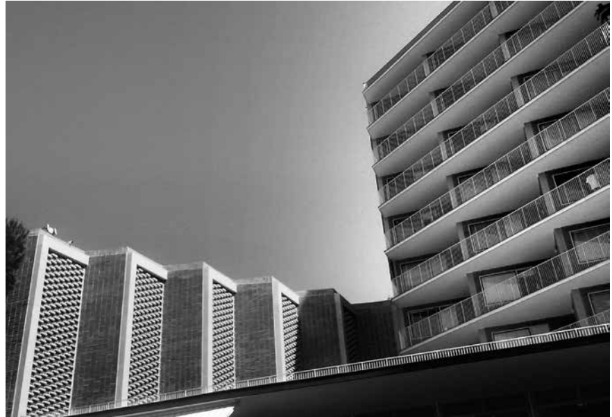
Fig. 25 Rafael de La-Hoz y José María García de Paredes, Colegio Mayor Aquinas (Madrid, 1953)
