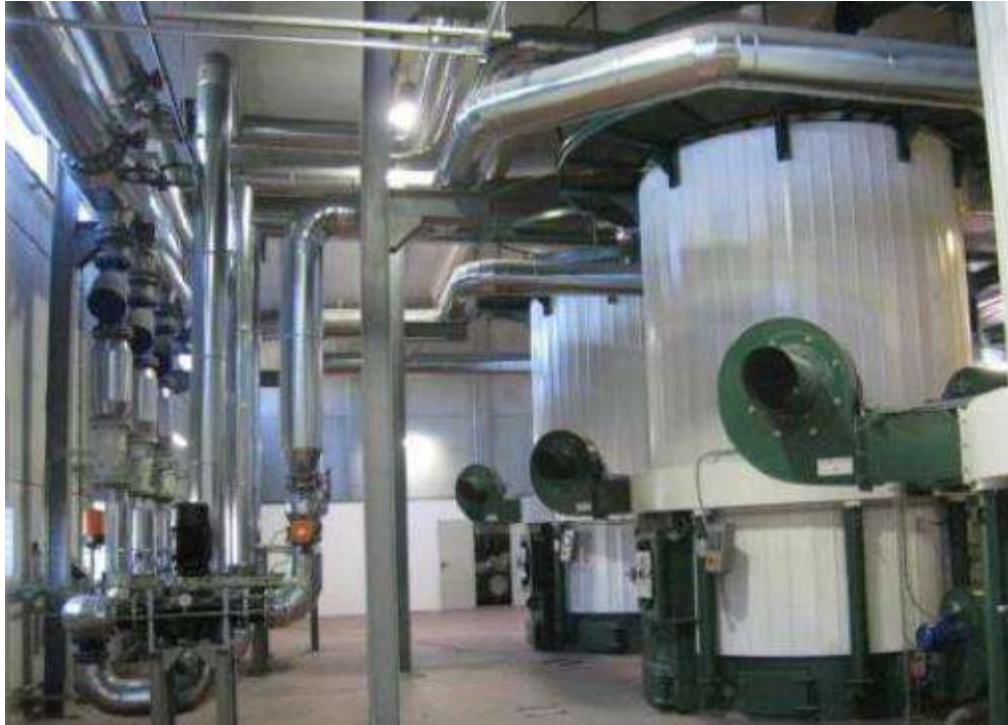
Figura 29. Calderas iniciales. . (Lorenzo, 2017) [107]
