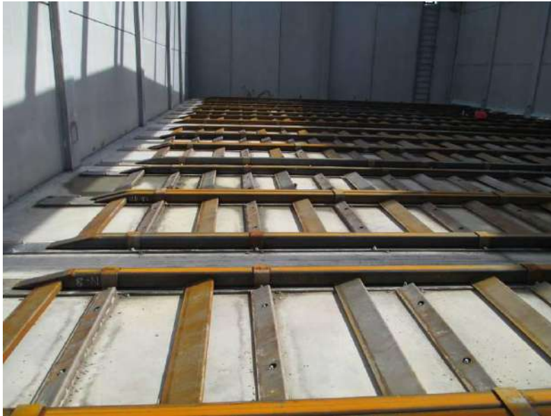
Figura 34. Piso móvil del silo.
