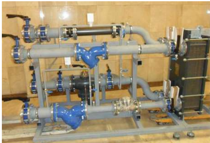
Figura 44. Subestación de calor. (Lorenzo, 2017) [107]
