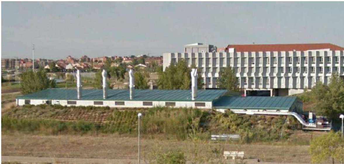
Figura 25. Vista posterior de la Central Térmica. Fachada Noroeste
