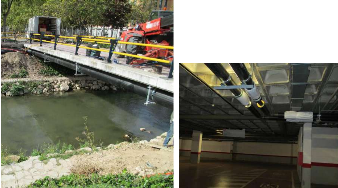
Figura 42. Red de distribución aérea.
