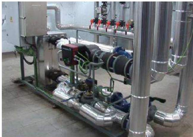
Figura 45. Subestación de calor. . (Lorenzo, 2017) [107]
