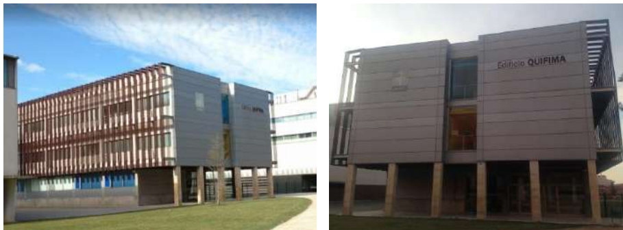
Figura 169. Fotografías del Edificio Química Fina y Materiales Avanzados (QUIFIMA) (D8)
