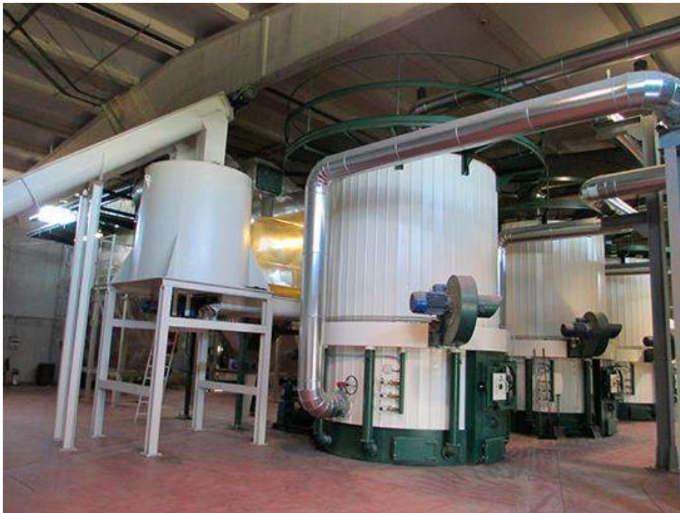
Figura 30. Sistema de alimentación a las calderas. (PREFIERES. Portal de Eficiencia y Rehabilitación, 2016) [79]
