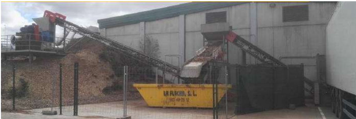
Figura 32. Líneas de llenado del silo. (Lorenzo, 2017) [107]
