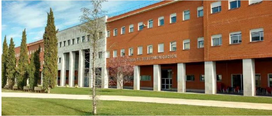
Figura 167. Fotografía de Telecomunicaciones e Informática (D7)
