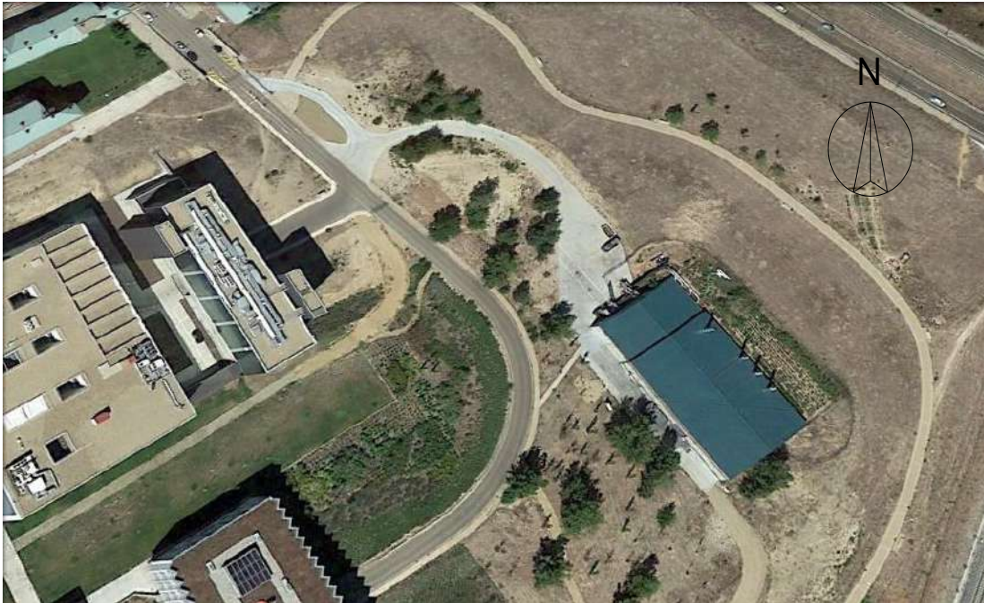
Figura 27. Vista aérea de la Central Térmica
