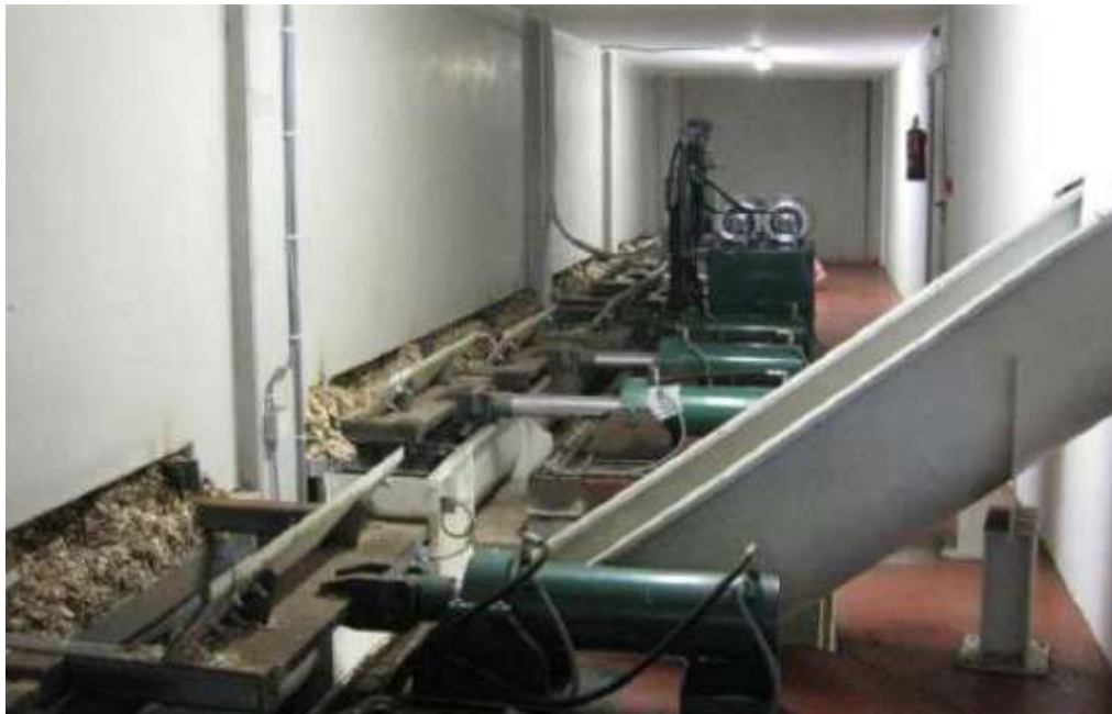
Figura 35. Tornillo sinfín desde el silo a la alimentación de las calderas. (Lorenzo, 2017) [107]
