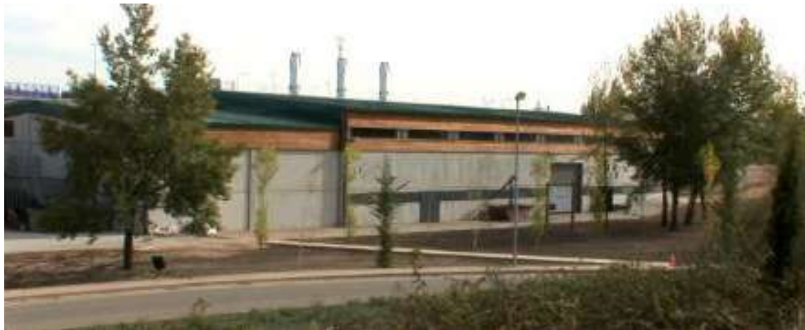
Figura 26. Fachada principal de la Central Térmica. Suroeste. (Lorenzo, 2017) [107]
