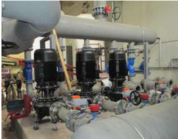
Figura 38. Grupos de bombeo del circuito secundario. (Lorenzo, 2017) [107]
