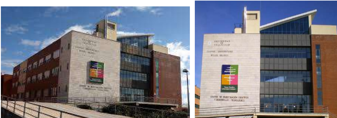
Figura 177. Fotografía del Edificio de I+D (D12)
