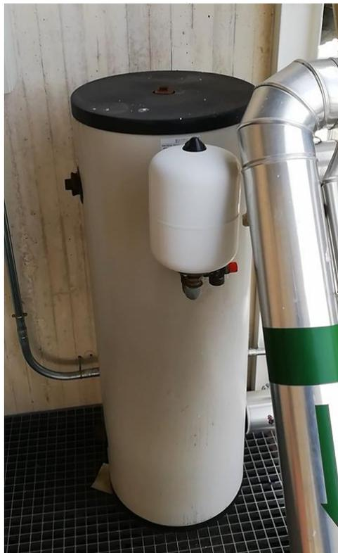
*Figura 26. Depósito de inercia de agua fría*
