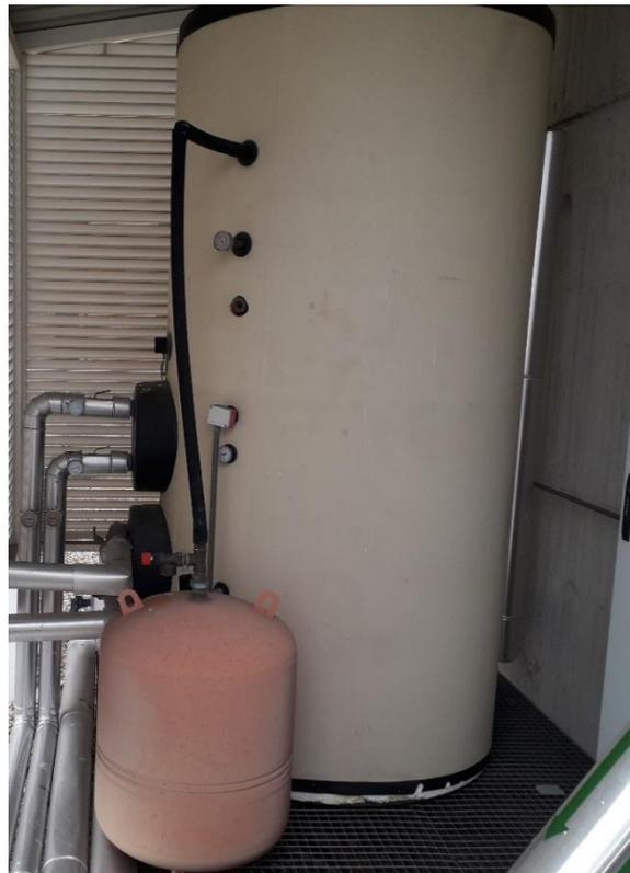
*Figura 25. Depósito de absorción*
