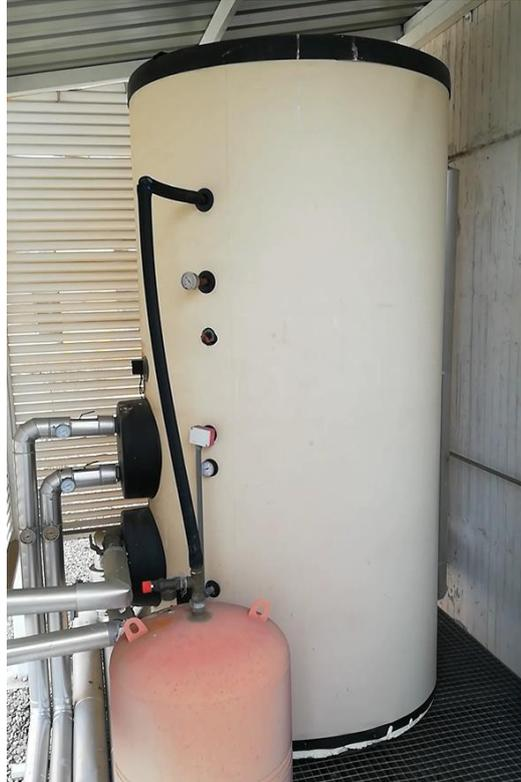
*Figura 15. Depósito de absorción*
