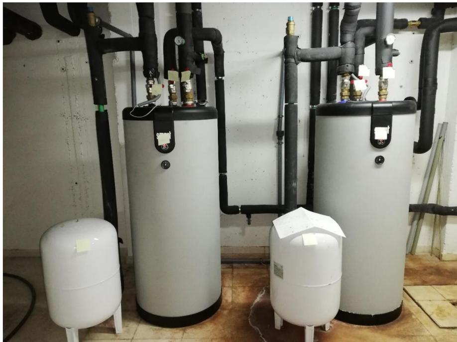
*Figura 18. Depósitos de ACS*
