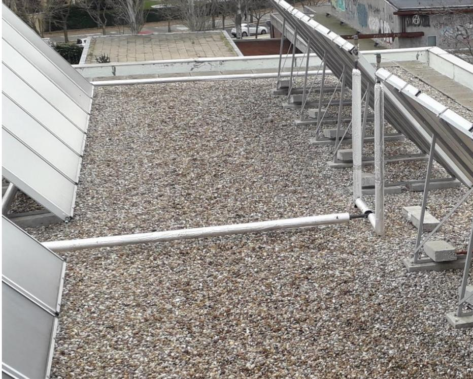
*Figura 11. Tuberías del circuito primario*
