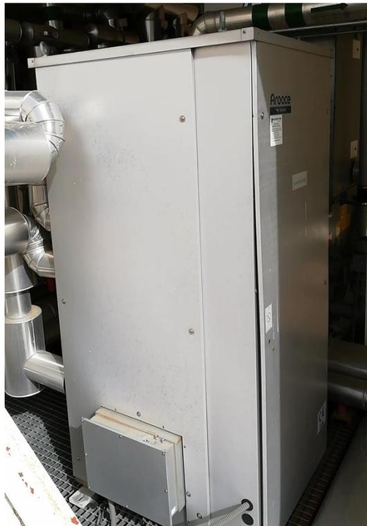
*Figura 10. Máquina de absorción*
