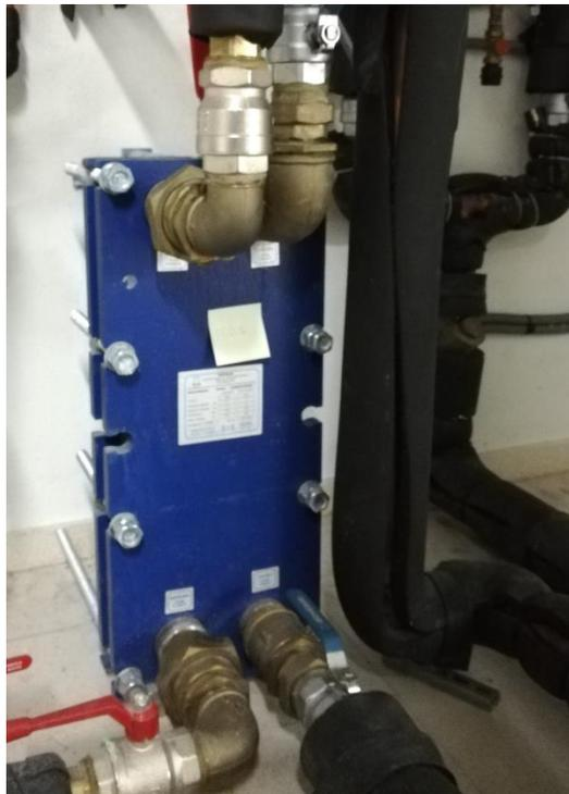
*Figura 14. Intercambiador de placas planas*
