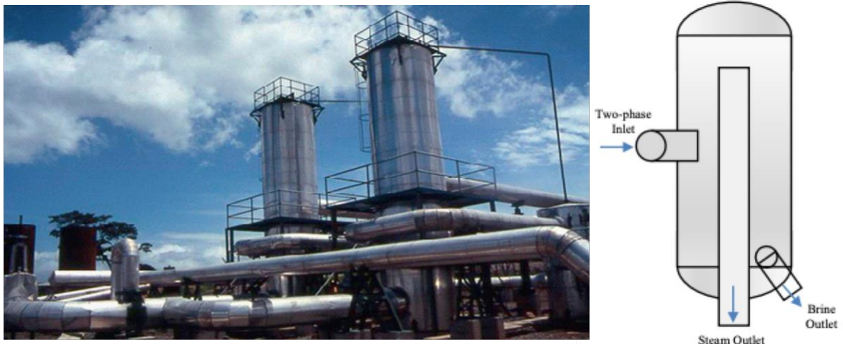
Figura 78. Esquema de un separador de ciclón vertical y separadores verticales de la central de Miravalles (De derecha a izquierda) [9], [41].
