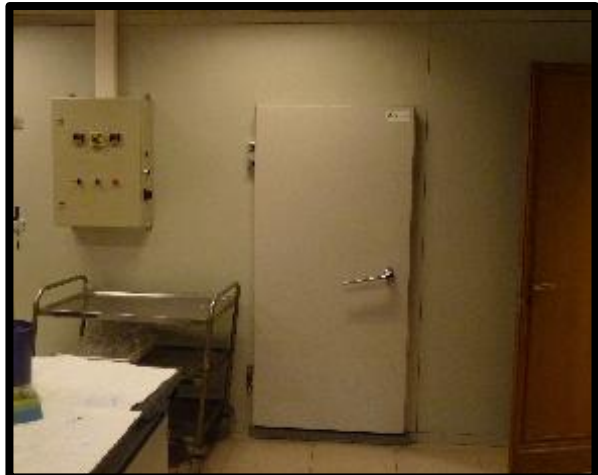
Foto 6. Exterior de una cámara visitable de cultivo
