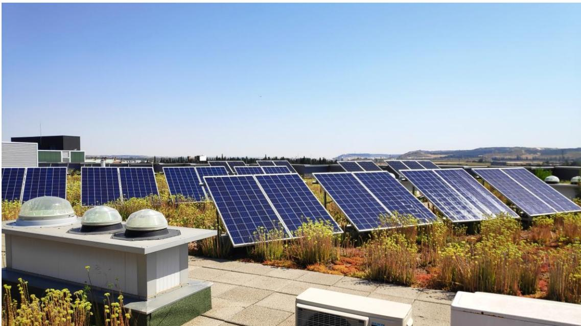
*Ilustración 5. Instalación fotovoltaica del edificio LUCIA.*
