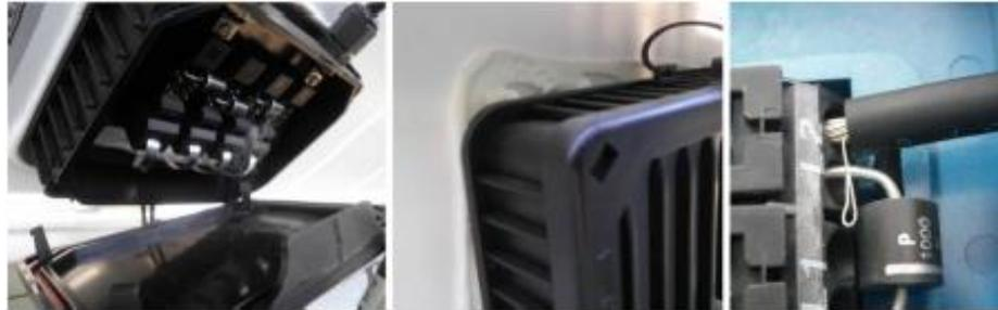
Ilustración 12. Defectos en la caja de conexiones.
