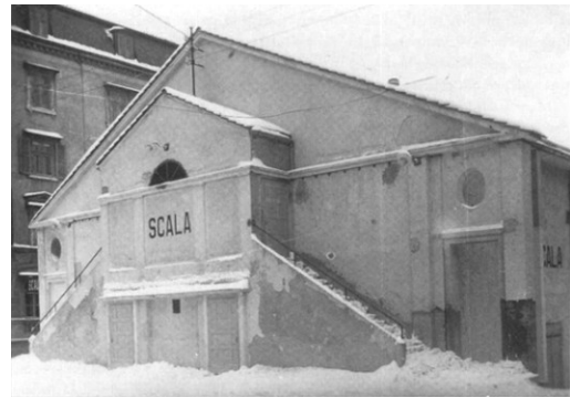
Figura 23. Le Corbusier, Cinema La Scala . Chaux – de – Fonds, 1916. Imagen del exterior
