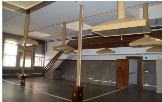
Fotografía realizada en mi visita al edificio.
