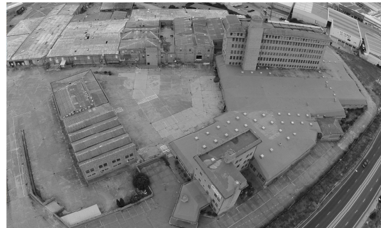
Imagen aérea de la fábrica "El Acueducto" de Curro Inza Fuente: imagen facilitada por el Ayuntamiento de Segovia
