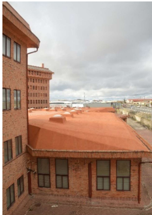
Fotografía de la cubierta Fuente: Imagen realizada en mi visita al edificio.
