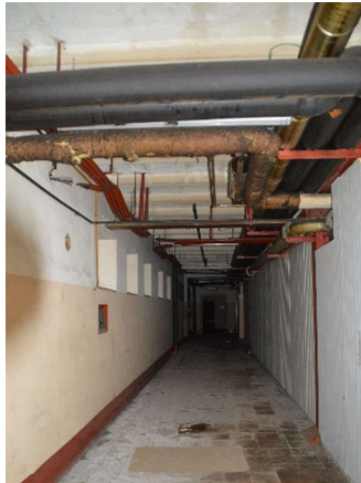
Fotografía realizada en mi visita al edificio.
