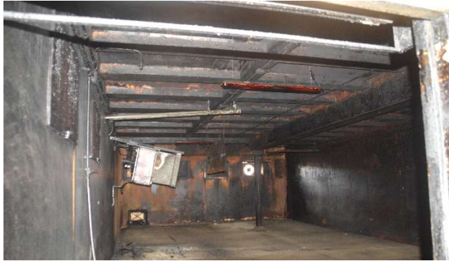
Fotografía realizada en mi visita al edificio.
