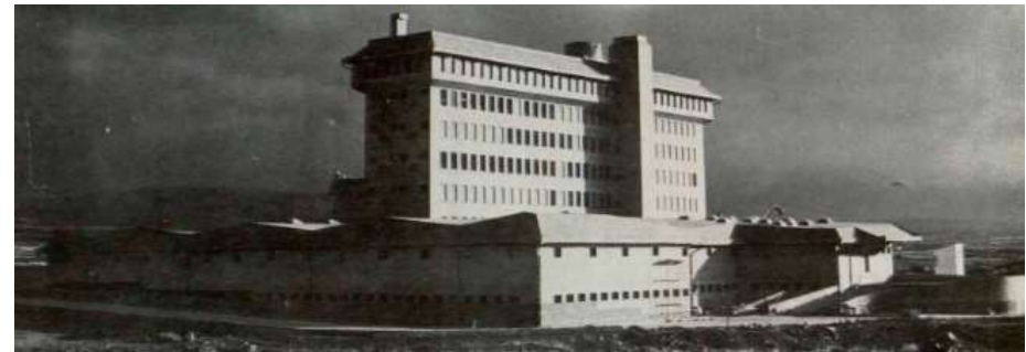
Fotografía en la que se percibe la expresividad de los volúmenes y la homogeneidad conseguida a través del manejo de los materiales. Fuente: Arquitectura, 1966, nº 95. Pág.18
