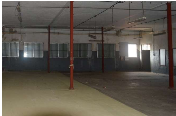
Fotografía realizada en mi visita al edificio.
