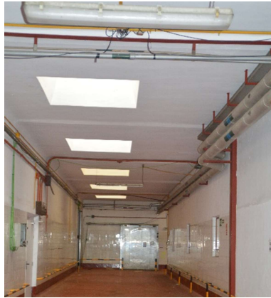
Fotografía realizada en mi visita al edificio.
