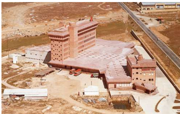
Imagen de la primera fase construida. Se aprecia la imagen brutalista que le otorgan los materiales cerámicos y su envolvente. Fuente: Imagen cedida por el actual propietario de la fábrica.
