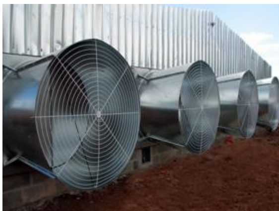
Figuras 12 y 13. Ventiladores de gran caudal por su parte exterior (izqda.) y por su parte interior (drcha.).
