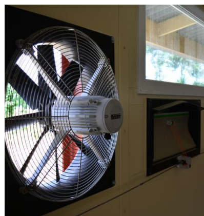
Figuras 12 y 13. Ventiladores de gran caudal por su parte exterior (izqda.) y por su parte interior (drcha.).
