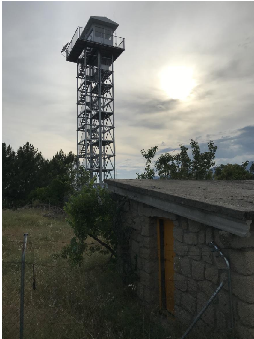
Figura 24. Puesto de vigilancia fija de la Comarca de Mombeltrán, “El Amoclón” en el MUP Nº 16 de Mombeltrán. (Fuente: Elaboración propia).
