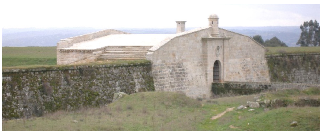
6a - Portas Exteriores e Interiores de Santo António . Fotografía exterior.
