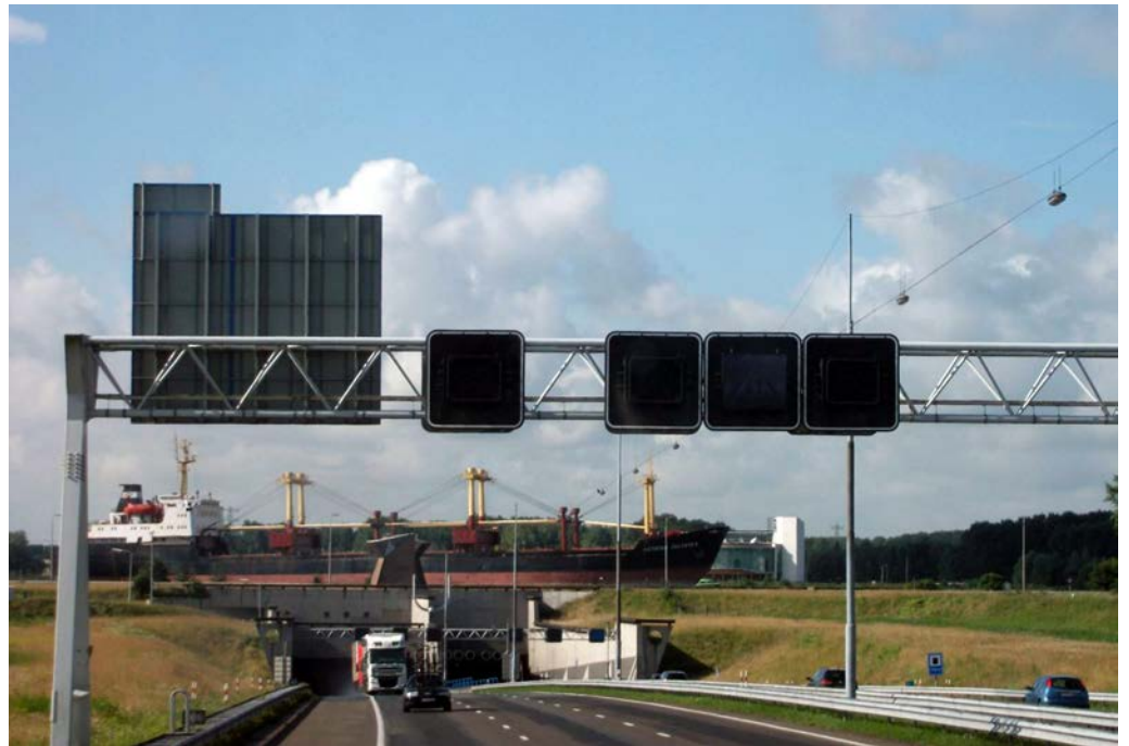
12 - Eusebio Alonso García. Canal navegable que pasa sobre la autopista. Holanda. 2017. Fotografía.
