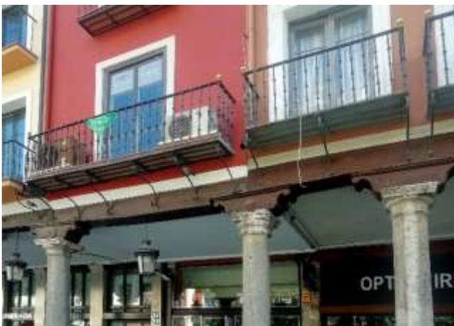
Imagen 206- Detalle soportales de la plaza. Columnas de piedra con vigas de madera.
