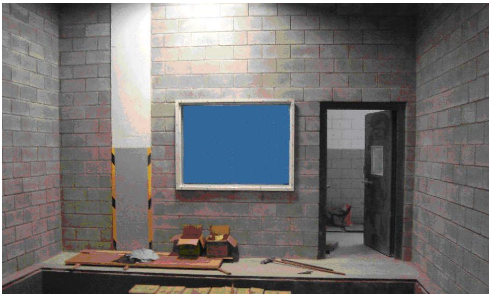
Fig.2.11 Muro de sala de ensayo en construcción
