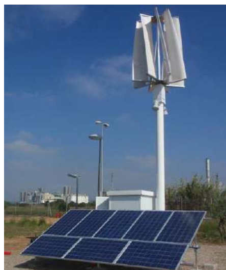
Figura 42. Ejemplo de instalación de energía solar híbrida. Fuente: https://www.todoensolar.com
