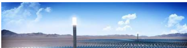
Figura 41. Ejemplo de instalación de energía termosolar concentrada. Fuente: https://avatarenergia.com/energia-solar-concentrada-indagan-mejores-formas-de-generar-energia-limpia-a-traves-de-ella/
