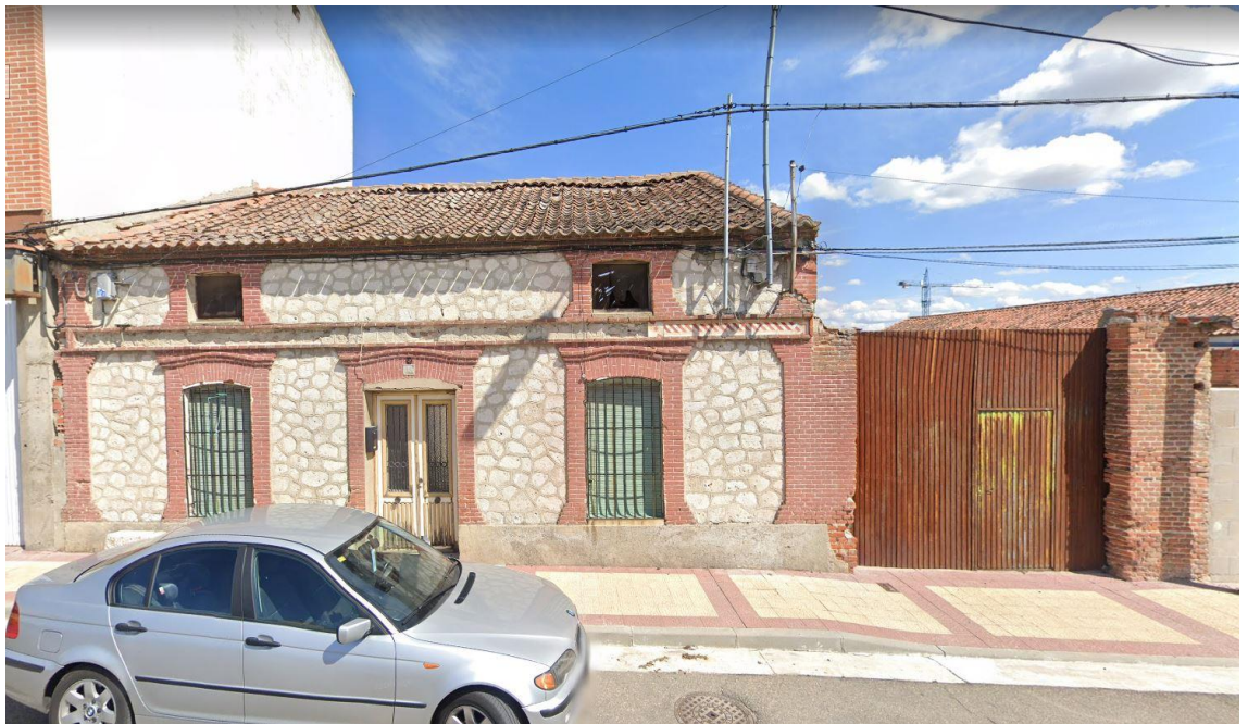
Figura 37 Fachada posterior vivienda unifamiliar
