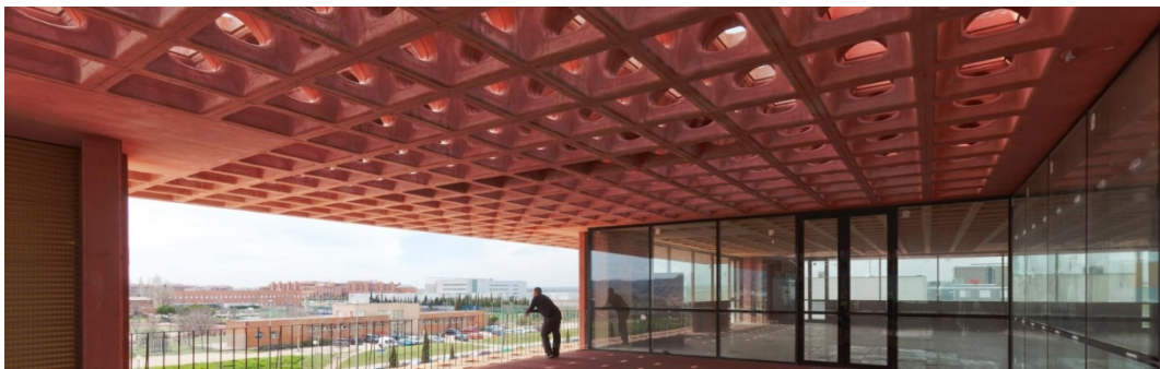
Ilustración 35. Fotografía real de un edificio equipado con el forjado HoleDeckHo45. Fuente: Holedeck, (2020).
