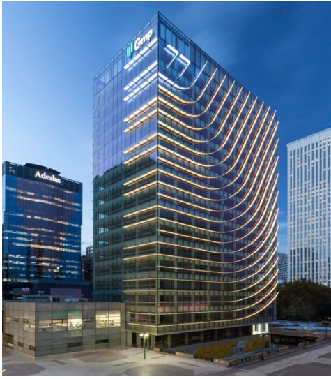
Ilustración 62. Edificio Castellana 77, Madrid. Fuente: (Plataforma Arquitectura Castellana 77, n.d.)
