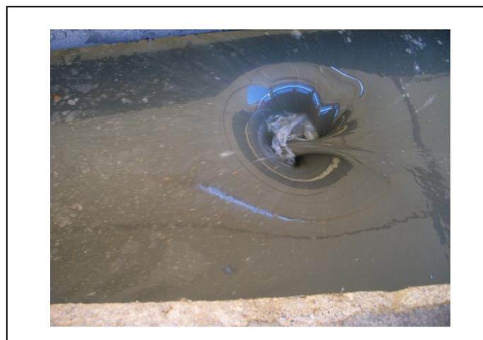
**Figura 14:** Conducto de Salida del Clarificado del Espesador Lleno
