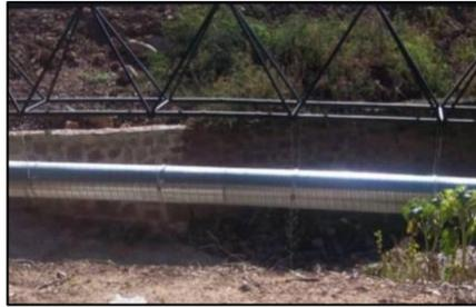
Ilustración 7-1. Colector de entronque entre el sistema de alcantarillado y la EDAR
