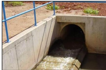
Ilustración 7-2. Canal abierto de la obra de llegada a la EDAR
