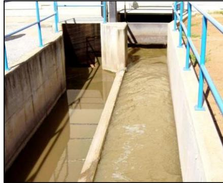
Ilustración 7-3. Vista del aliviadero lateral (zona izquierda de la imagen)
