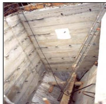
Ilustración 6-2. Tanque Imhoff de hormigón
