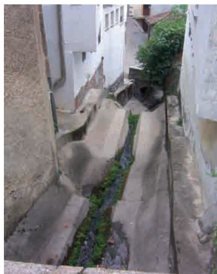
Puente y canalización de agua en calle Fuente Chica / la Fuente Grande / detalle de regatera a la altura del Rollo.
