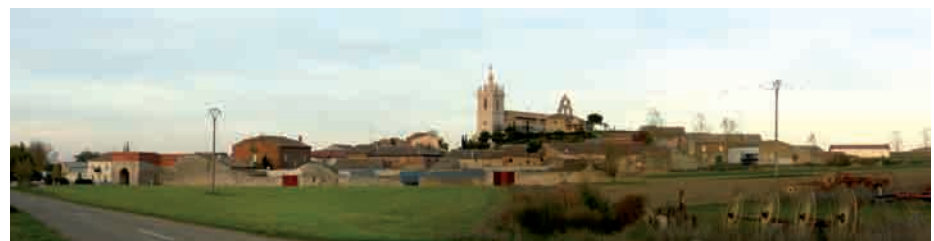
La imagen de Támara desde la carretera hacia Piña de Campos.
