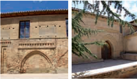
Detalles de la arquitectura mudéjar en Sahagún.
