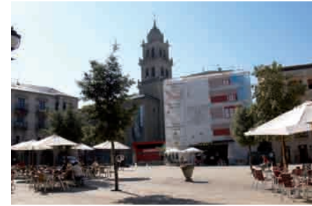
Basílica de la Encina. Construida sobre la primitiva iglesia de Santa María, centro religioso de la villa medieval, el templo actual es del s. XVI-XVII. Tiene planta de cruz latina, cabecera poligonal, un crucero que apenas sobresale de aquella, y una nave rectangular dividida en tres tramos por contrafuertes interiores. El presbiterio y el crucero se cubren con bóvedas de crucería, mientras que los dos primeros tramos de la nave lo hacen con bóveda de cañón apuntada.
