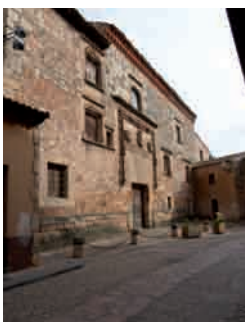
Palacio de Contreras. La portada de sillería está recuadrada con un cordón franciscano, y las ventanas son de arco rebajado o cuadrangular con guarniciones de bolas, molduras e impostas.
