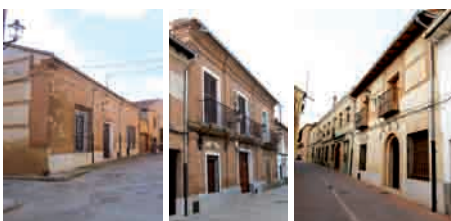
Detalles de tres aleros de diferentes edificaciones de Alaejos.
