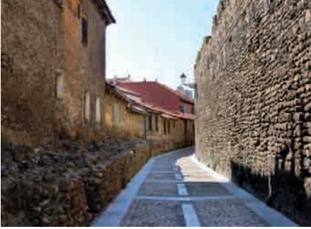
Vista de la cerca medieval desde la Calle de las Cercas.
