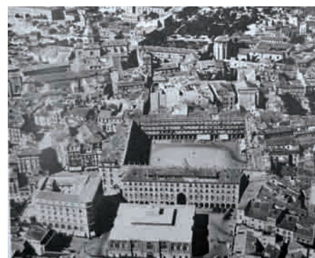
Panorámica de la plaza Mayor. (Fuente: “Salamanca bajo el rigor de la moderación”, en: Revista de Urbanismo. Laboratorio de Urbanismo. Barcelona, 1990).
