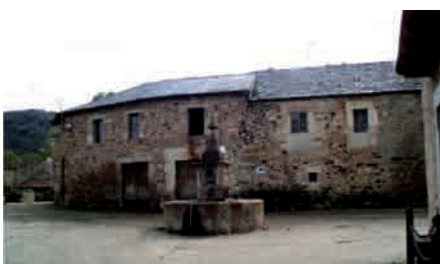
Imagen de las construcciones del entorno del Palacio.
