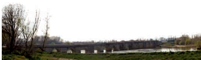
Vista del Puente sobre el río Pisuerga.
