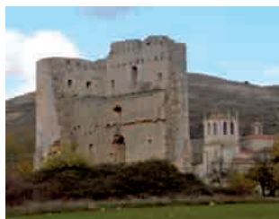
Torre de los Padilla.
