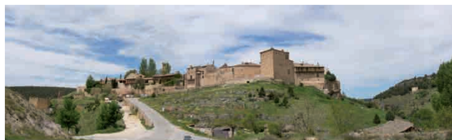
Vista del conjunto desde el camino de acceso que conduce hasta la Puerta de la Villa.
