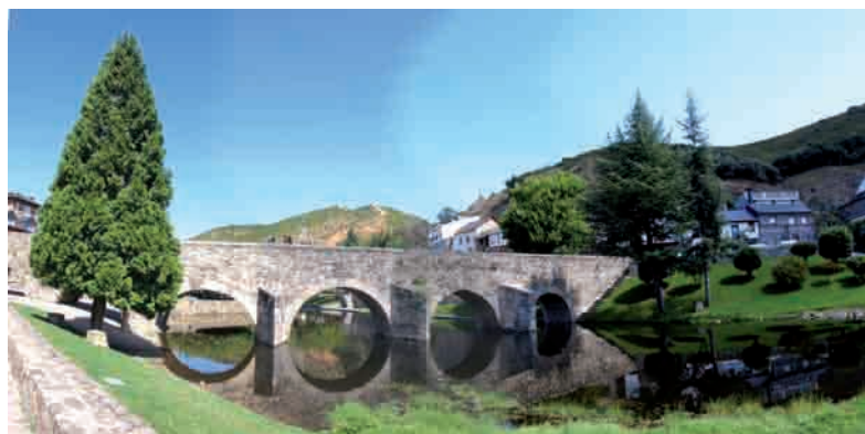
Vista del puente sobre el río Meruelo.
