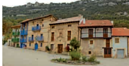
Construcciones tradicionales de la plaza.
