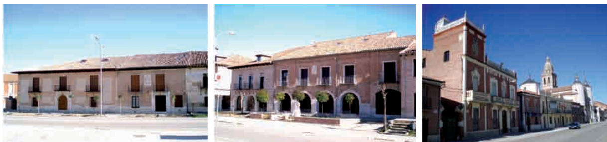
Distintas vistas de las edificaciones de la calle principal de Rueda.
