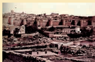
1860. Fotografía desde la vía férrea. Oficina del Ayuntamiento.
