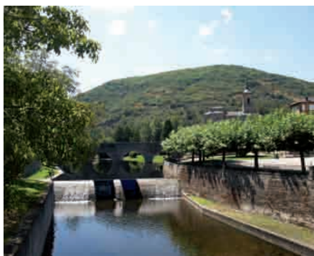
Vista del Puente sobre el río Meruelo.
