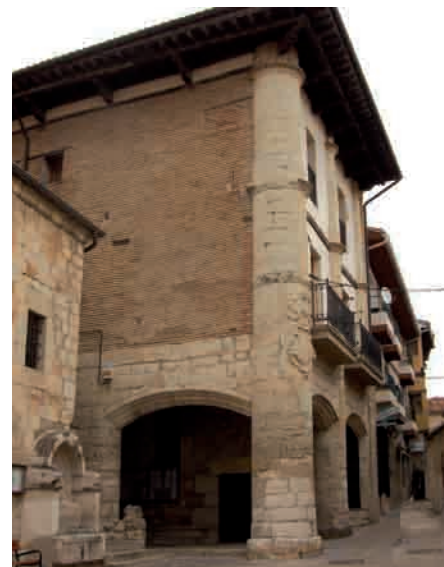
El ayuntamiento, con un característico acceso porticado.
