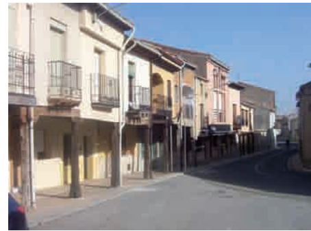
Pórticos en la calle Real.
