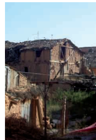
Aspecto del núcleo urbano de Rejas, caracterizado por las construcciones de adobe mezclado con piedra caliza y estructura en madera de roble.
