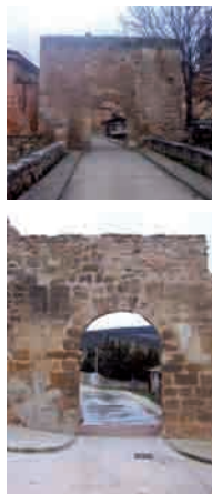
Dos de las puertas que daban paso al antiguo recinto amurallado.
