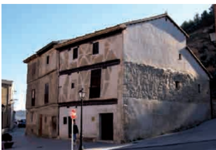
Viviendas en la Plaza del Salvador, construcciones del siglo XVI realizadas con entramados de madera.
