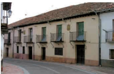
Vista de un conjunto de viviendas en Riaza.
