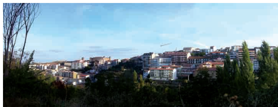
Panorámica del frente sur de Béjar. De Este a Oeste se aprecian los restos del lienzo amurallado, la torre de Santa María, el castillo-palacio de los duques de Béjar y la torre de San Juan Bautista.
