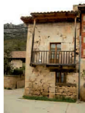
Distintas tipologías de solanas. Los ejemplos mejor conservados se encuentran en la calle Real y la plaza. Se caracterizan respecto a los de otras poblaciones por los esbeltos pies derechos que apoyados sobre el vuelo del balcón sustentan una parte del tejado.
