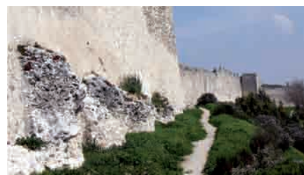
Vista de uno de los tramos de la muralla.
