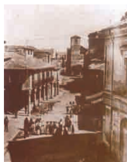
Fotografía de 1910. (Fuente: SÁNCHEZ, J. L. Las Calles de Palencia. 1997). En primer plano chafalán del palacio de Tordesillas, esquina con Colón. Al fondo, torre de San Lázaro y a la izquierda vista de los primitivos soportales, llamados del Inquisidor sobre los que fue levantado el edificio de la Diputación Provincial.
