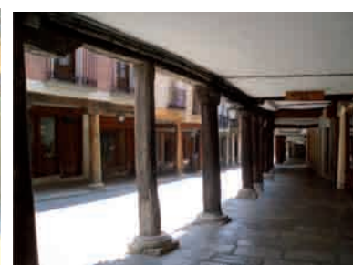
Vistas de las edificaciones porticadas en la calle de la Rúa.
