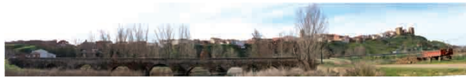
Vista del puente sobre el Cea.
