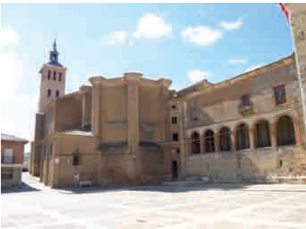
Vista del conjunto Iglesia-Palacio desde la plaza mayor.
