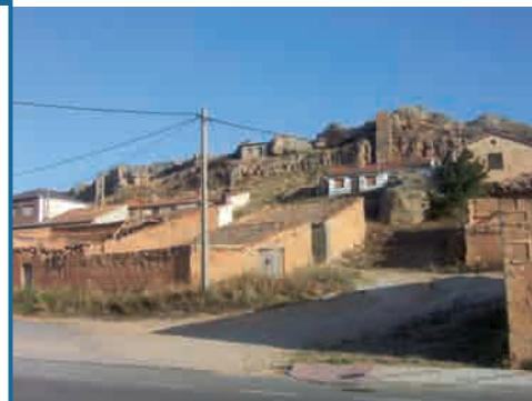
Bodegas y edificaciones anejas de adobe en Osma.
