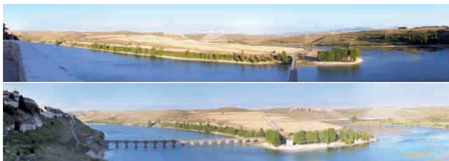
Vistas del puente que atraviesa el embalse.
