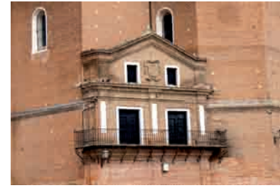
Iglesia de San Pedro. El balcón corrido de forja está situado entre la cabecera y el testero de la nave de la Epístola. Rematado con frontón y gárgolas de piedra que incluye el escudo pontificio de San Pedro.
