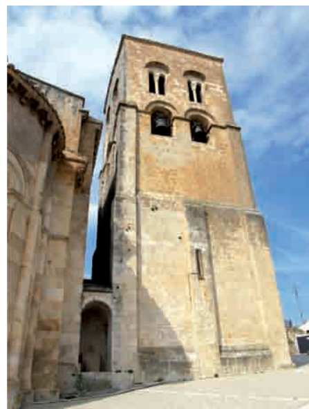
Torre de la iglesia del Salvador. Situada en la parte del evangelio y separada del edificio consta de tres cuerpos. Los dos superiores tienen dobles ventanas con arcos de medio punto. Se une a la nave del templo, a través de un pasadizo abovedado.
