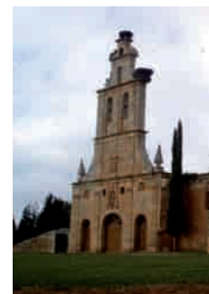
Portada del antiguo convento de San Francisco de Asís. Fundado en 1214, la fachada que se conserva debió realizarse en el s. XVIII. Fachada de sillería con tres arcos de medio punto daban acceso al vestíbulo de la Iglesia. Sobre la puerta principal se coloca la imagen de San Francisco y rematando el conjunto, una espadaña.
