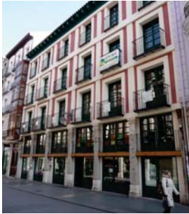
Ejemplos de sustituciones fachadistas [Fuente: reportaje del trabajo de campo]
