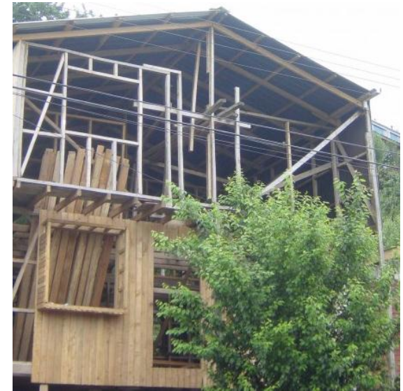
Fig.139 Construcción de un palafito. Estructura en madera sistema ballom frame. Fuente: C. Quintans. «Palafitos de Pedro Montt y Gamboa en Castro y Palafitos de Mechuque». Revista Tectónica Blog, Publicado el 13 de Diciembre 2009. En [ http://tectonicablog.com/?p=2184 ]
