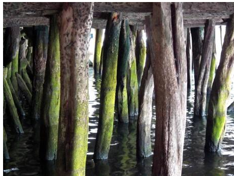
Fig.140 Marea baja, altura de los pilotes sobre la superficie. Fuente: [http://www.construmatica.com/construpedia/Archivo:Palafitos_chilo%C3%A9_by_Any_Manetta_,_Flickr.jpg]
