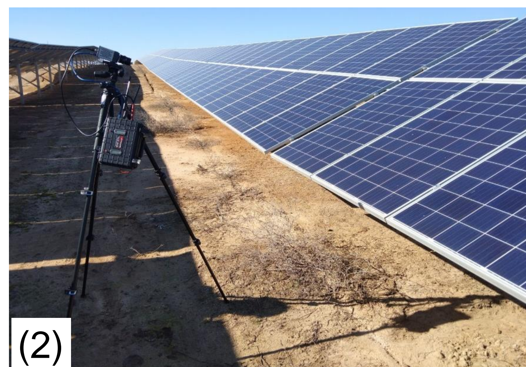
Trípode con cámara y caja de control trabajando en planta
