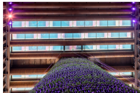
Figura 69. Cristales fotovoltaicos techo del pabellón.
