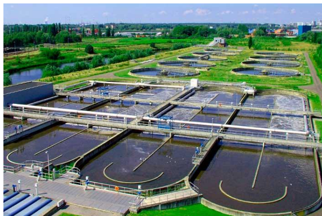
Figura 2: Zona de pretratamiento EDAR
