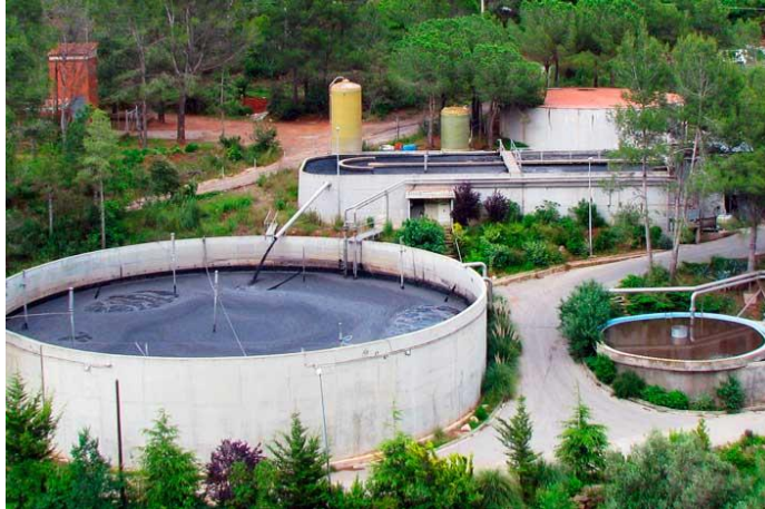
Figura 4: Zona de decantación secundaria EDAR
