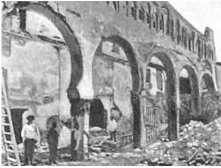
Fig. 16 Sinagoga Mayor de Segovia Restos del incendio de 1899. Segovia. www.wikipedia.org
