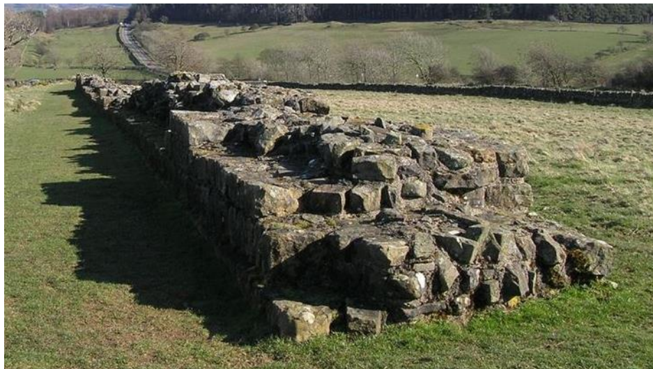
Figura 10. Sección del muro estrecho construida sobre los cimientos del muro ancho en Black Carts ( Historic England ).
