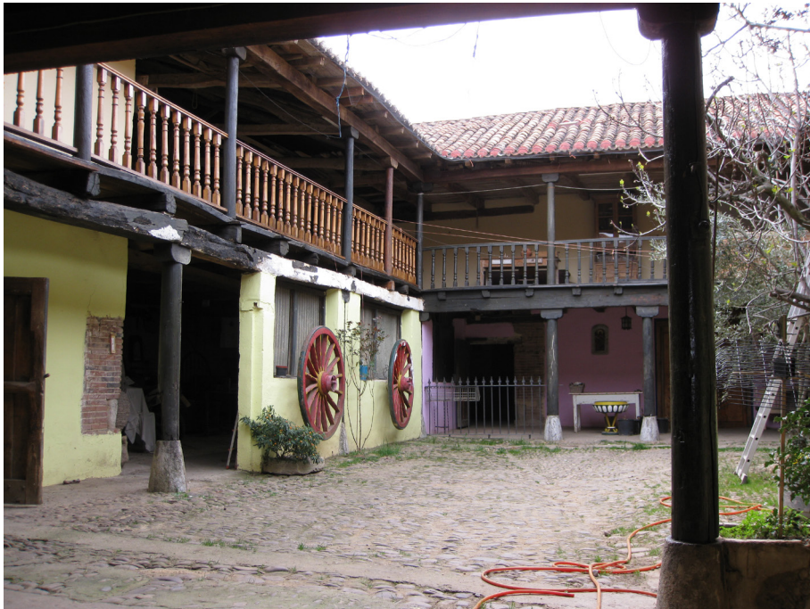
Figura 11. Patio de casa con corredor en Villaturiel (León). Fuente: Javier Pérez Gil.
