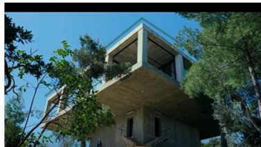
Maika se dirige a su puesto de trabajo. Desde este ángulo se aprecia la potente diagonal tan importante en este edificio, la que apunta al este y funciona de acceso.
