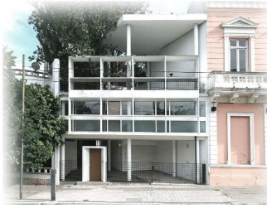
Fachada norte Casa Curutchet.
