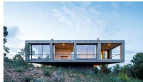
La estructura delimita visualmente los espacios. Los cerramientos son de hormigón y vidrio. Las habitaciones, el salón y la cocina se revisten de madera (sensación de hogar) y la primera planta se deja de hormigón visto (textura rugosa).
