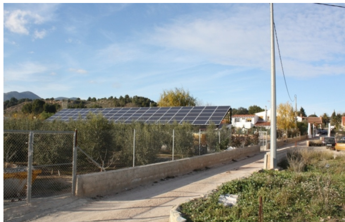
Figura 4. Ejemplo de pequeña instalación fotovoltaica.
