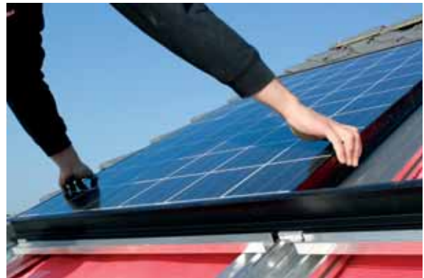
Colocación simple de los paneles
