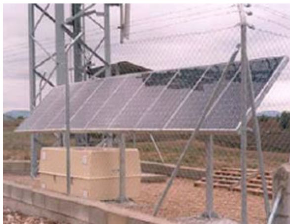
Figura 7. Paneles fotovoltaicos en estación de telefonía.
