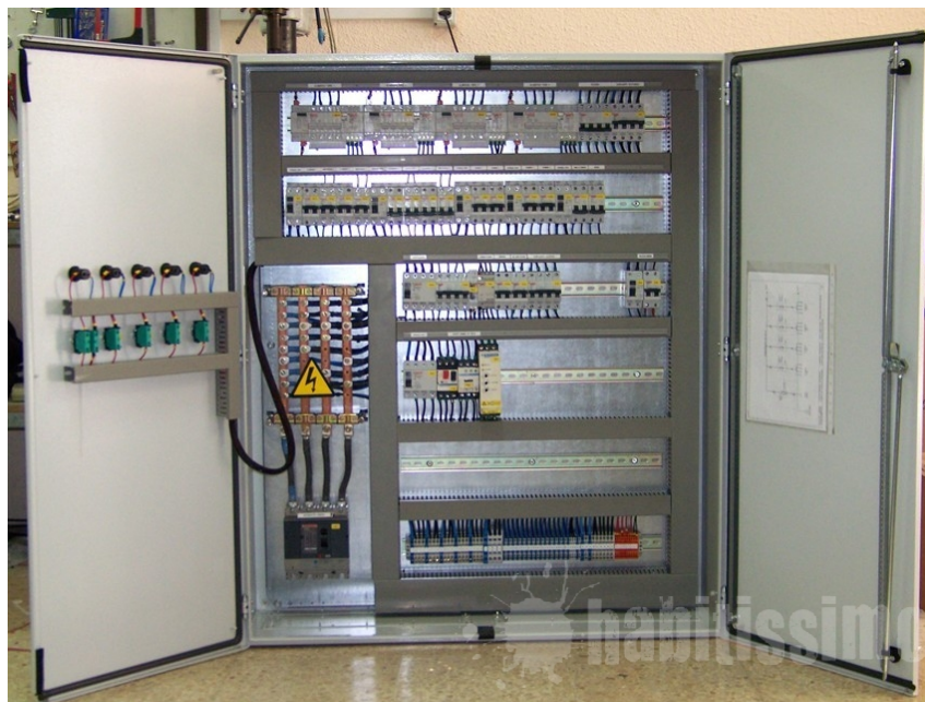
Figura 2. Cuadro eléctrico industrial.
