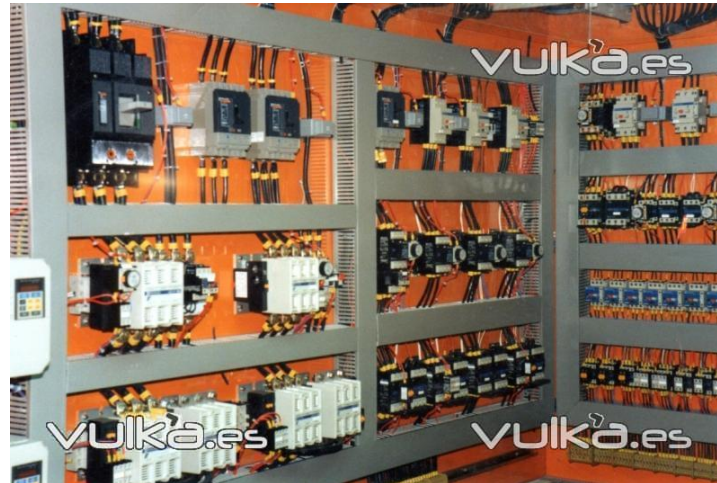
Figura 1. Colocación de objetos en cuarto eléctrico.
