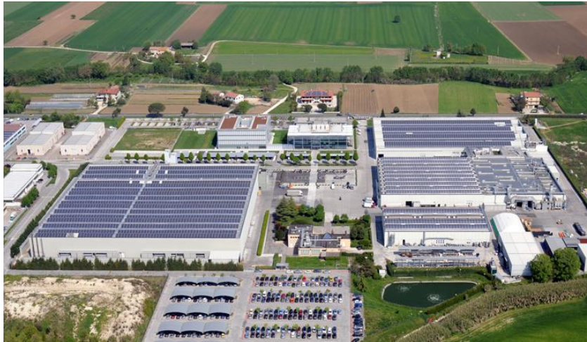
Figura 5. Gran instalación fotovoltaica.
