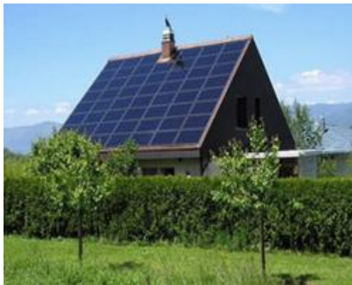
Figura 6. Instalación en vivienda aislada.
