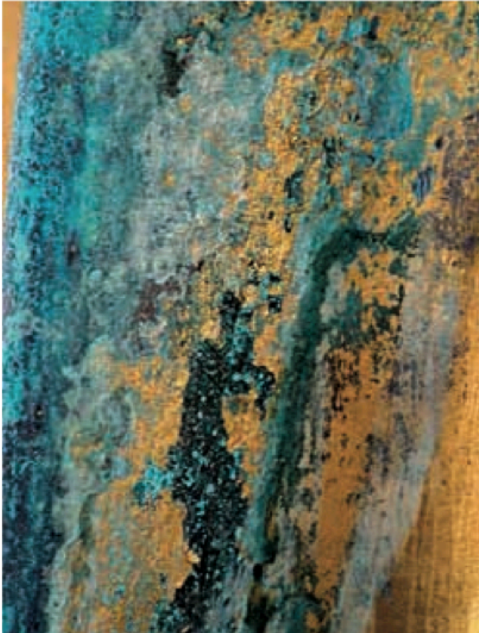
Detalle de procesos de corrosión
