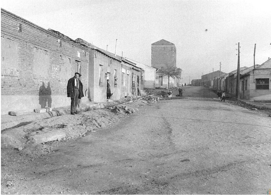
Fig. 8. Obras de ejecución de la red de saneamiento en Pajarillos Altos, en Calle Villabáñez, arteria principal alrededor de la que se desarrolló el núcleo original del barrio hacia mediados del siglo XIX. Fuente: Archivo Municipal de Valladolid (s. f.).
