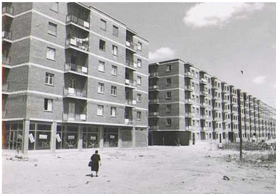
Fig. 20. Grupo de viviendas de protección oficial y promoción privada en el barrio de La Rondilla a comienzos de la década de 1970, con total ausencia de elementos urbanísticos. Aislado en sus inicios, se vio rodeado por bloques de similares características en los siguientes años. Fuente: Archivo Municipal de Valladolid (s.f.).
