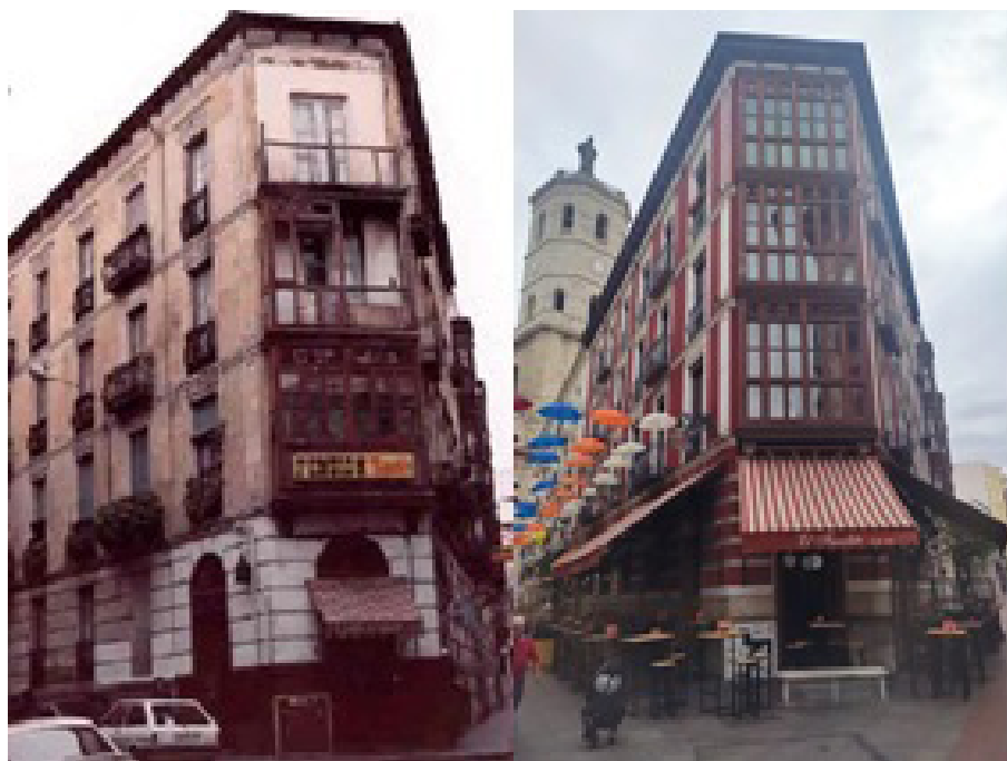
Fig. 35 y 36. En la imagen izquierda, edificio en la esquina entre calle Núñez de Arce y Calle Cascajares antes de comenzar las obras del ARI. Fuente: VIVA (ver nota a pie de página nº 36). Imagen derecha, situación después del ARI. Fuente: Fotografía del autor, septiembre de 2023.
