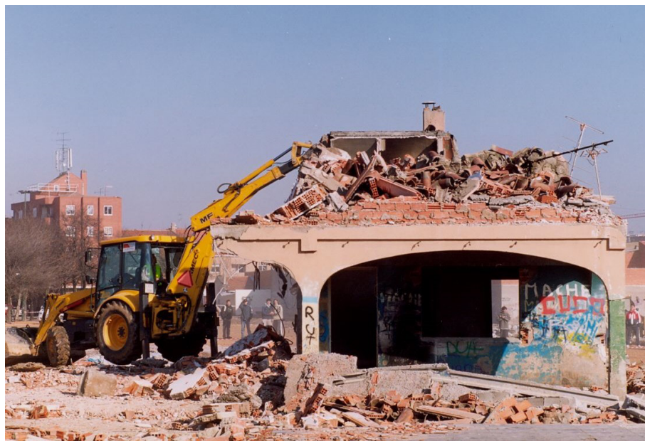
Fig. 29. Demolición de una de las últimas viviendas del Poblado de la Esperanza. El último derribo que terminaba con este guetto se produjo en 2002. Fuente: Archivo Municipal de Valladolid (s.f.).
