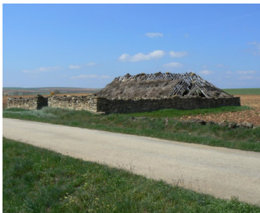
Fig. 1. Aprisco con cubierta vegetal (centeno) en la carretera de Barahona a Alpanseque, 200 metros antes de llegar a este último, en la provincia de Soria. Fuente: Ángel Coronado, BIPE.
