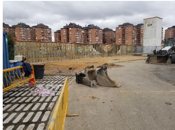
Fig. 58: Intervención en la rotunda de la calle Pilar Miró. Tratamientos previos de preparación antes de la aplicación de los distintos sustratos.
