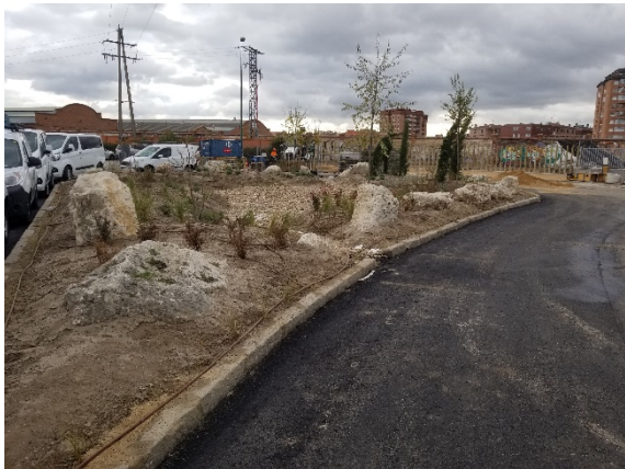
Fig. 57: Intervención en la rotunda de la calle Pilar Miró. Tratamientos previos de preparación antes de la aplicación de los distintos sustratos.
