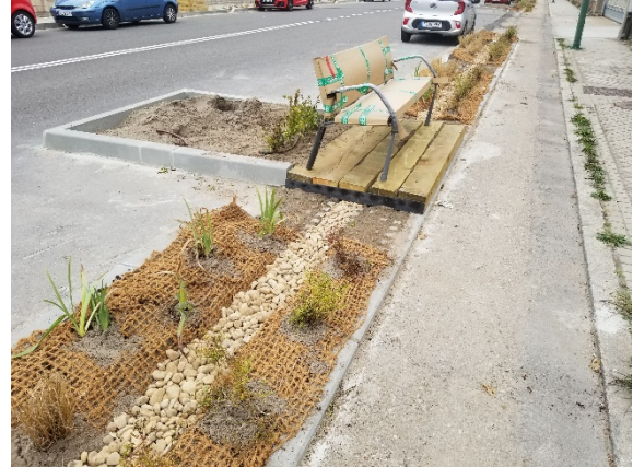
Fig. 45: Intervención en la avenida Norte de Castilla. Ejecución de la cuneta verde.
