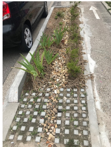
Fig. 47: Intervención en la avenida Norte de Castilla. Especies ornamentales en cuneta verde con los sustratos M2 y M3 (23-05-22).
