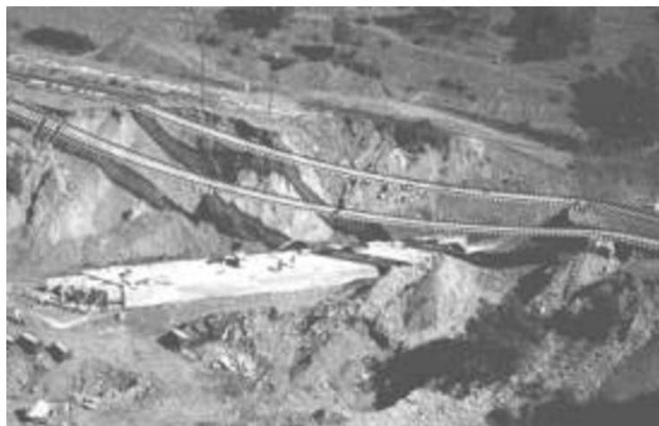
Figura 4. Desmoronamiento de 200 m. del terraplén del ferrocarril Villalba – Ávila, entre los puntos kilométricos 99 y 100. (arroyo de Majada Honda). Fuente: Antonio Sánchez.
