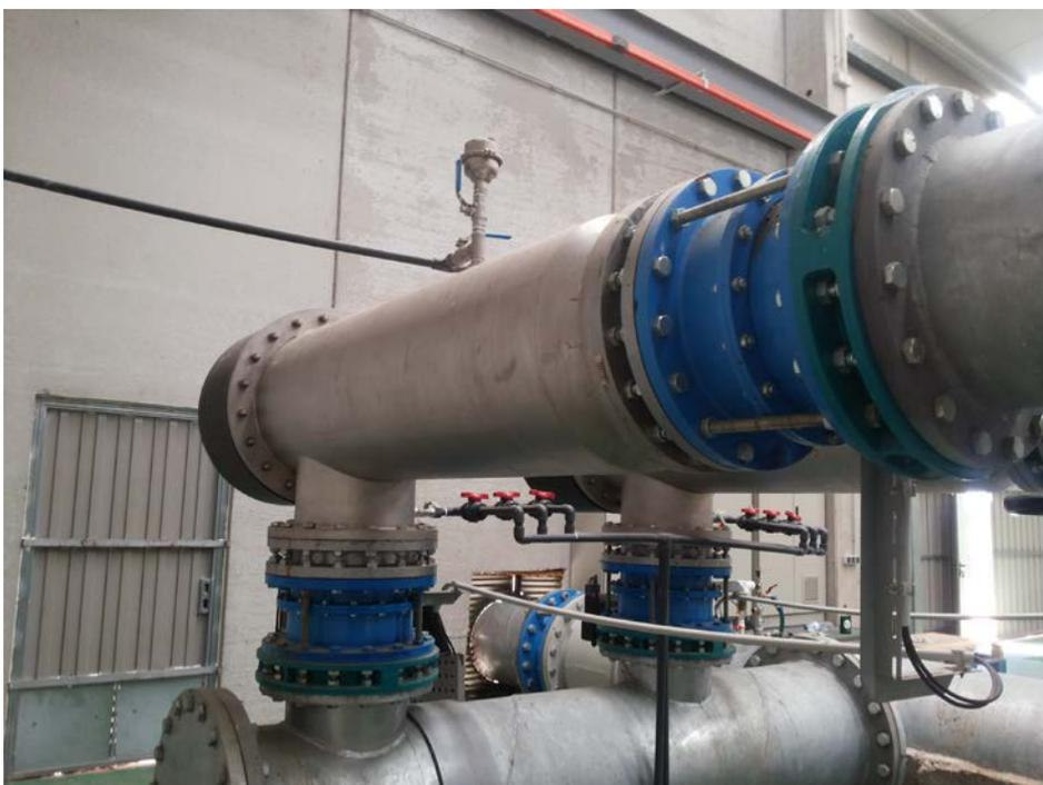
Foto 13: Reactores, salida a riego
