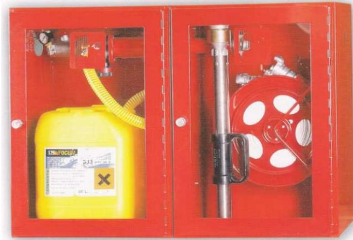
Figura 13: Sistema de protección con espuma
