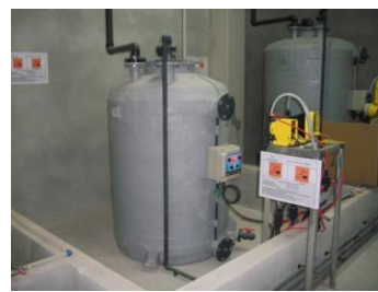
Foto 4: depósito de PACI
