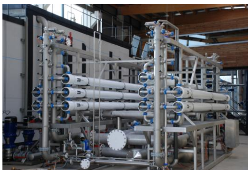
Foto 1: Unidades de ultrafiltración (UF) de la ETAP
