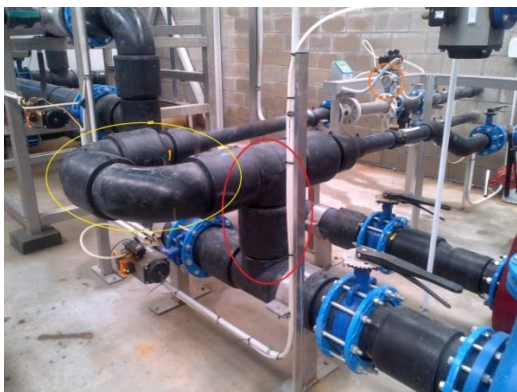
Foto 12: distribución inicial de las tuberías
