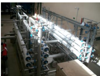
Foto 5: membranas de UF
