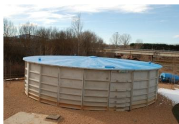
Foto 9: depósito de agua tratada
