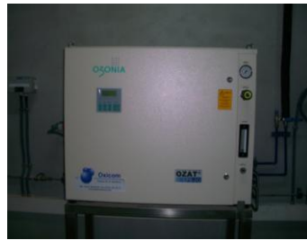
Foto 3: sistema de generación de O 3
