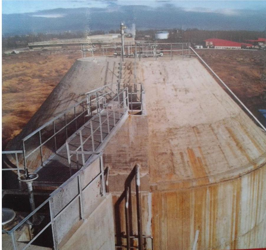
Ilustración 5 - Digestor de fangos
